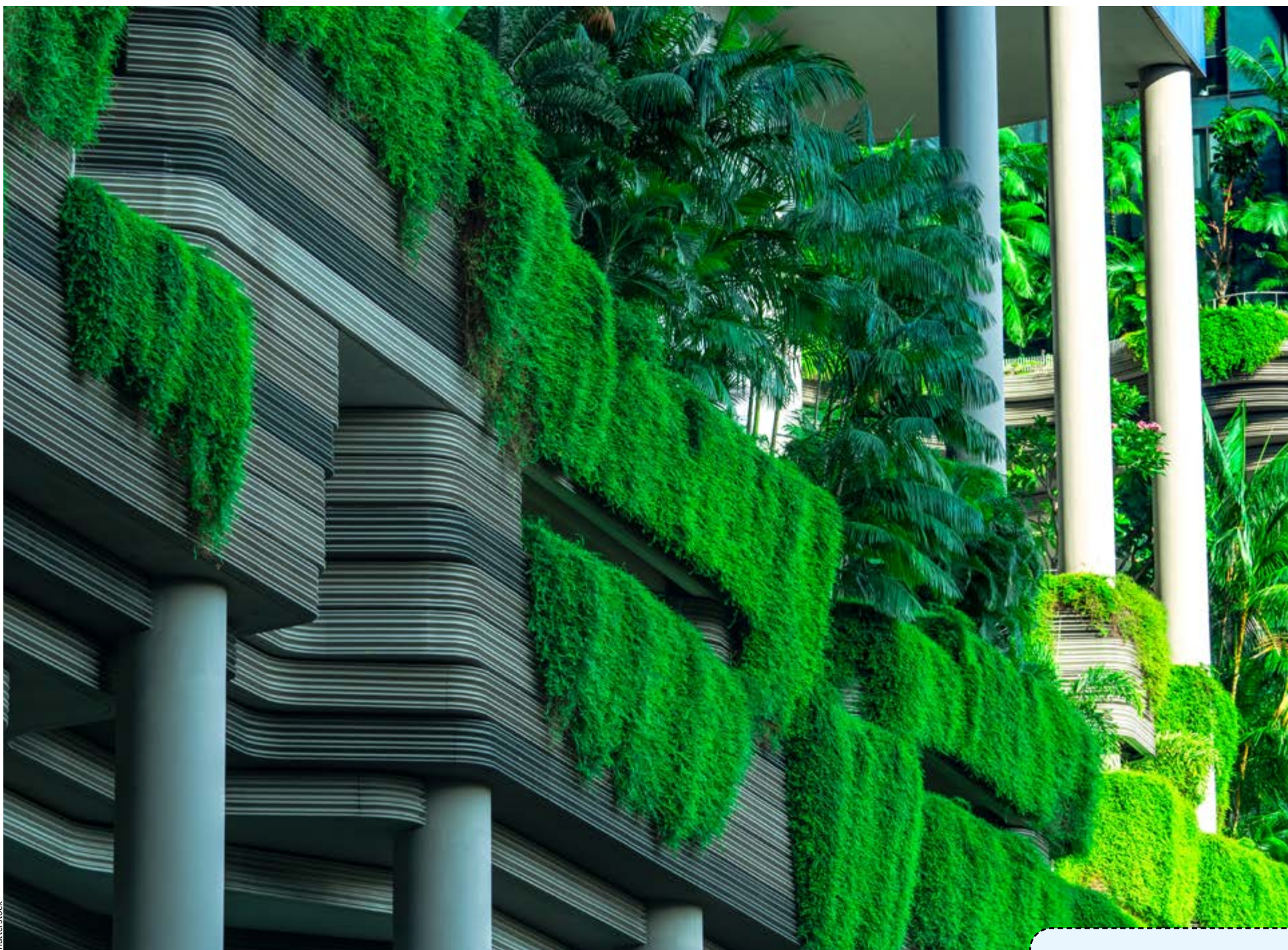
Fachada do condomínio Tree House, em Cingapura: jardim vertical filtra poluentes e dióxido de carbono, resfriando os espaços internos.
